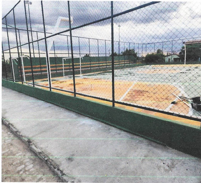
Foto 16- Pintura da parede do alambrado e pintura da quadra.
