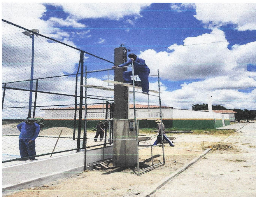
Foto 04 – Execução da reforma do poste.
