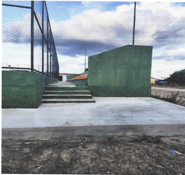
Foto 12- Pintura da arquibancada.
