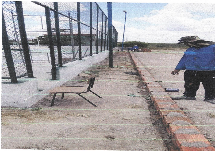
Foto 02 – Execução do passeio.
