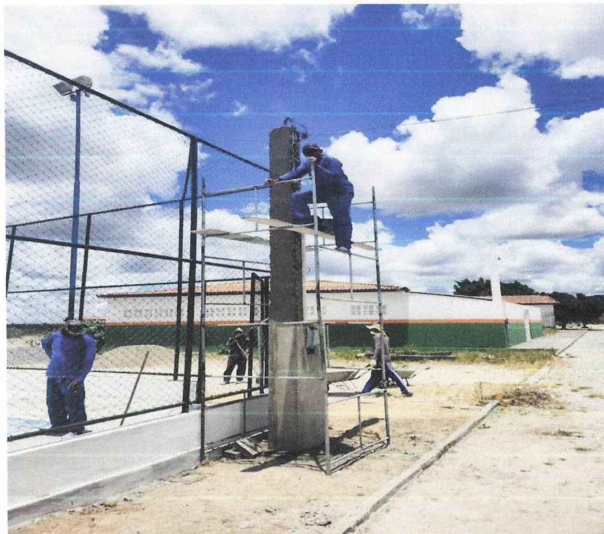
Foto 03 – Execução da reforma do poste.
