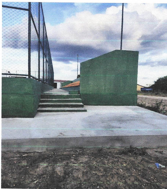
Foto 15- Pintura de arquibancada.
