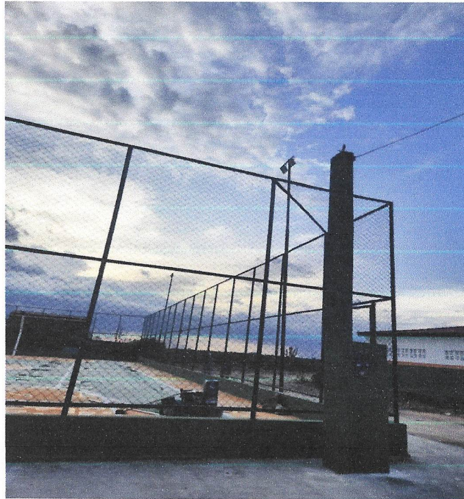
Foto 18- Execução do padrão do poste.
