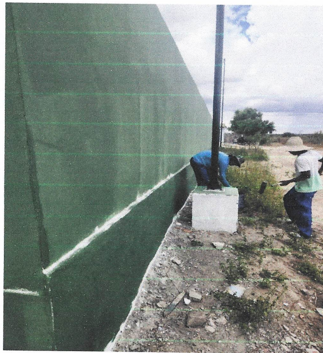
Foto 11- Pintura da arquibancada.
