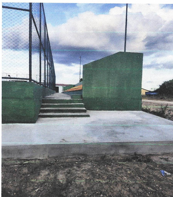
Foto 14- Pintura de arquibancada.
