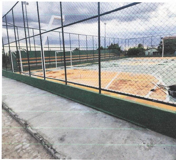
Foto 17- Pintura da parede do alambrado e pintura da quadra.
