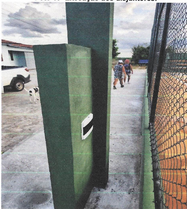
Foto 20- Execução dos disjuntores.
