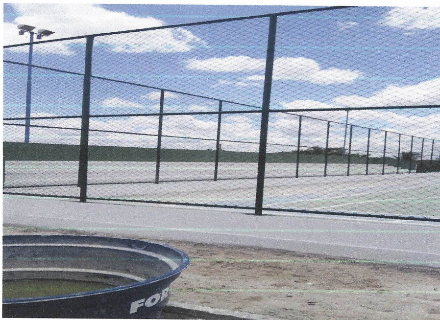
Foto 07- Execução de aplicação de selador
