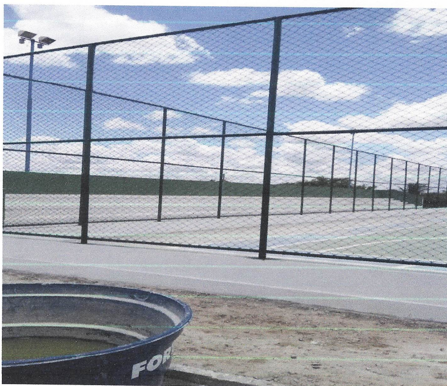
Foto 08- Execução de aplicação de selador
