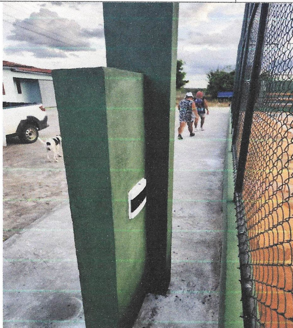
Foto 19- Execução dos disjuntores.
