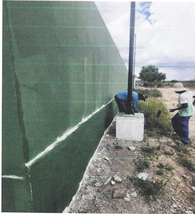
Foto 11- Pintura da arquibancada.
